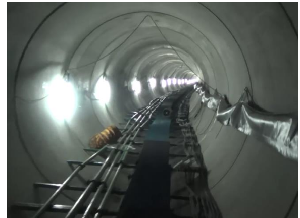
チリウン川放水路建設事業
