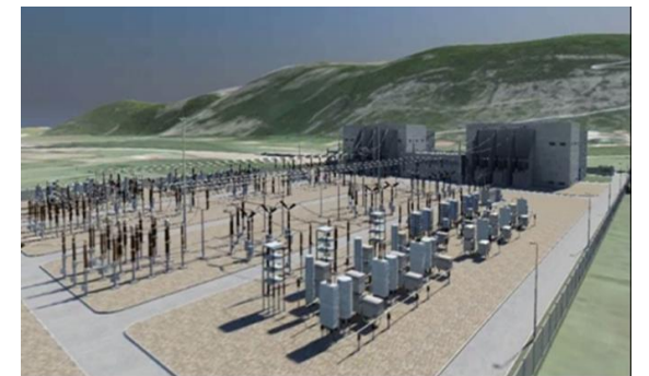
イタリア・モンテネグロHVDC変換所 42
