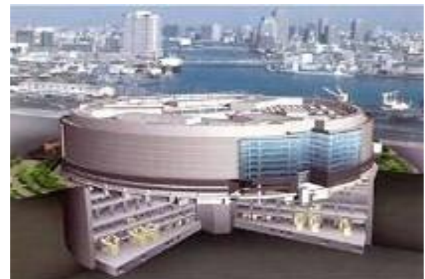
東京電力・新豊洲変電所
